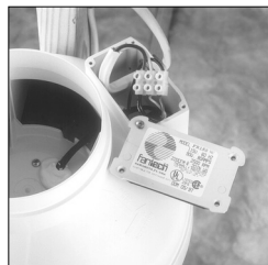
Câblage Romex - Vue de dessus.
