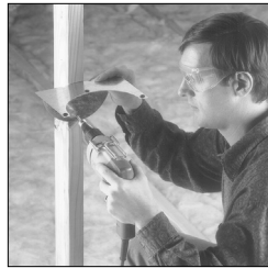
Fixer le support de montage (NB).
