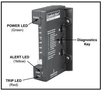
Figure 2. Comfort Alert<sup>™</sup> Diagnostics Module
